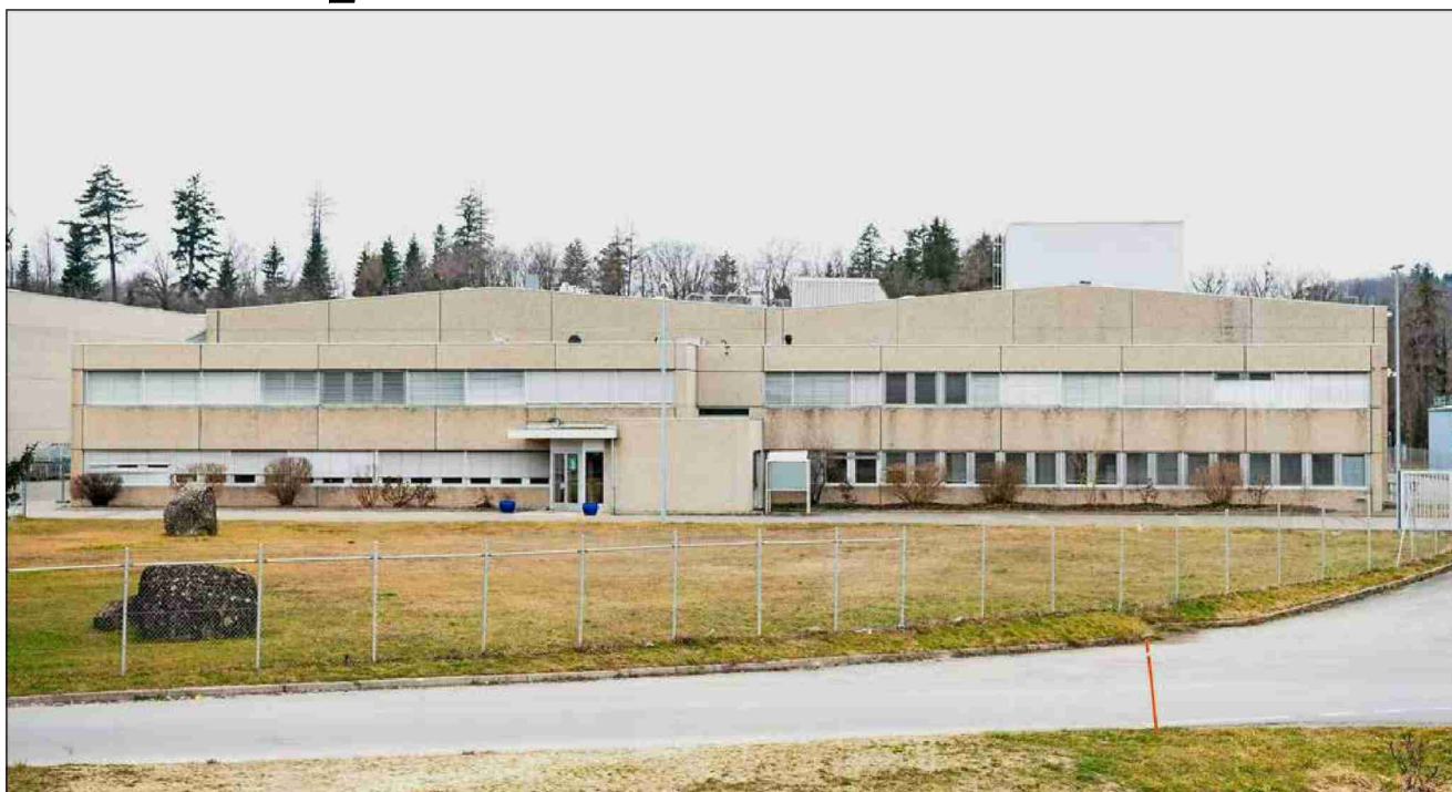
Plusieurs lignes de production seront installées sur l'aile nord du site de La Maillarde dès le deuxième semestre 2023. Elles devraient être opérationnelles d'ici 2025. THOMAS DELLEY
