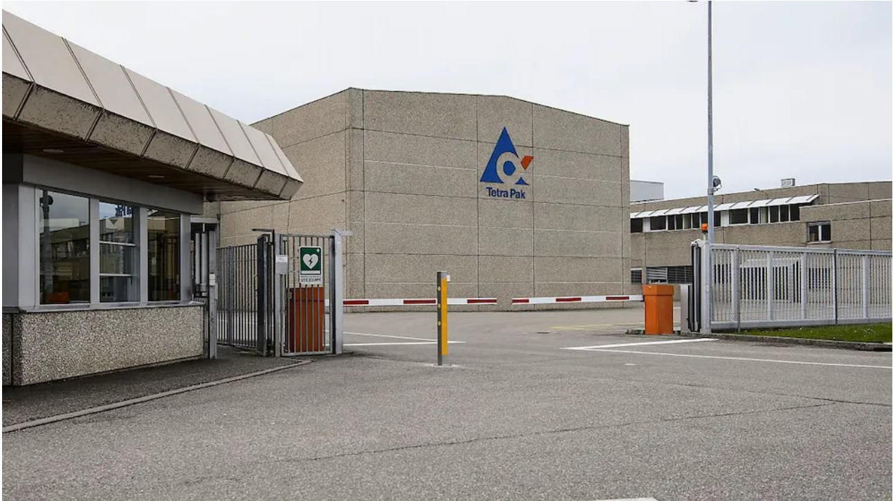
Le site de La Maillarde à Romont (FR) réhabilité, qui doit accueillir Rolex dès 2025, fut jadis exploité le géant suédois de l'emballage Tetra Pak (archives). ATS
